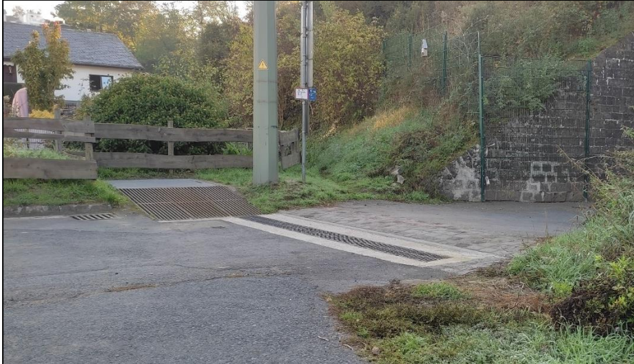
Abbildung 38: Querrinne und Einlaufbauwerk vor der Rabenbergstraße aktuell
