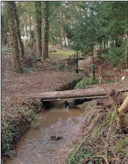
Abbildung 80: Niedrige Brücke am Segbach
