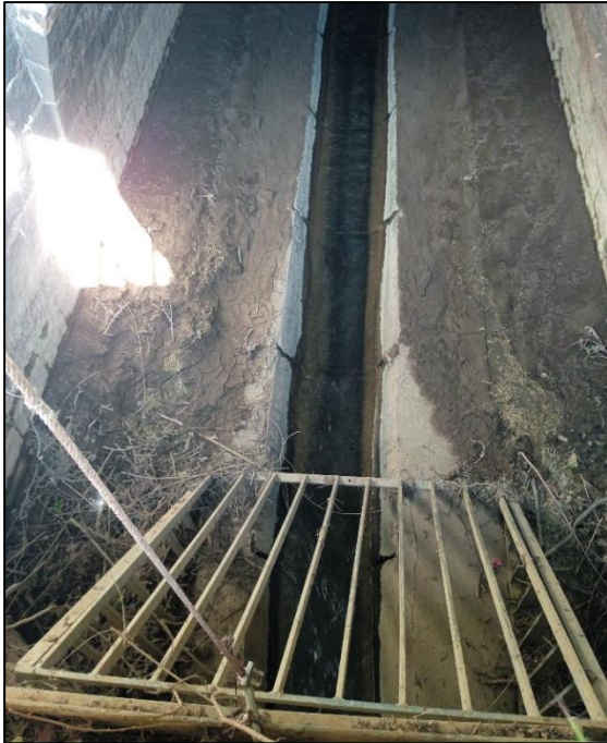
Abbildung 41: Einlauf in die Verrohrung - Innenansicht
