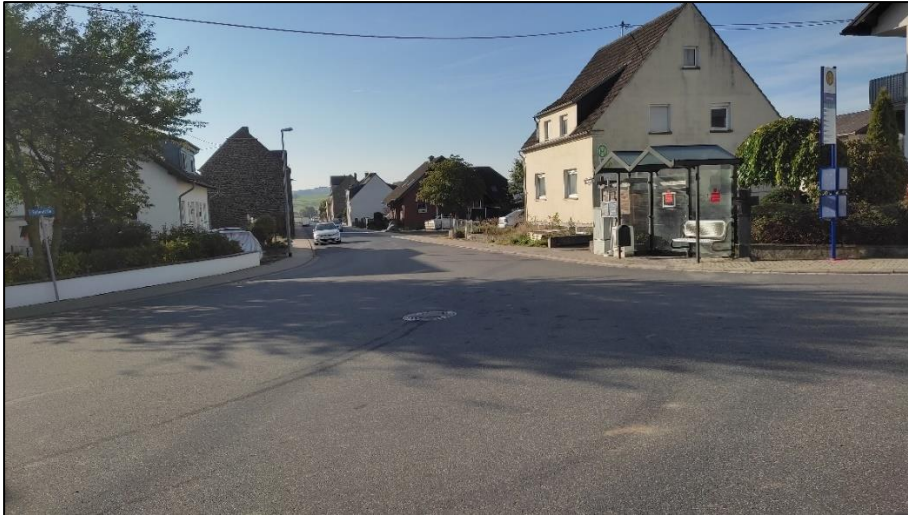
Abbildung 54: Senke im Kreuzungsbereich Fallerstraße - Kottenheimer Straße
