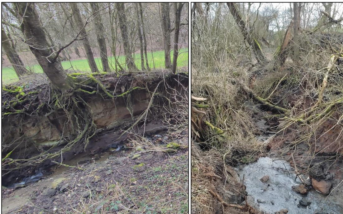
Abbildung 78: Freigespültes Wurzelwerk und Totholz am Segbach
