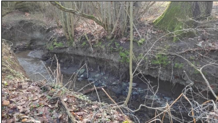
Abbildung 74: Stark erodiertes Ufer des Segbaches
