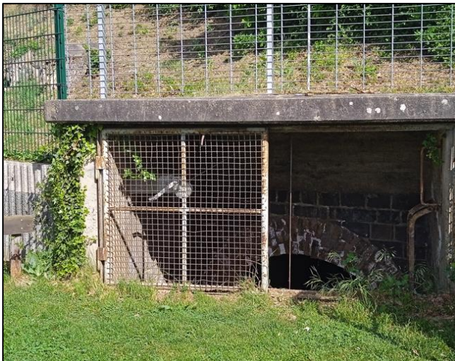
Abbildung 42: Einlauf in die Verrohrung am Spielplatz
