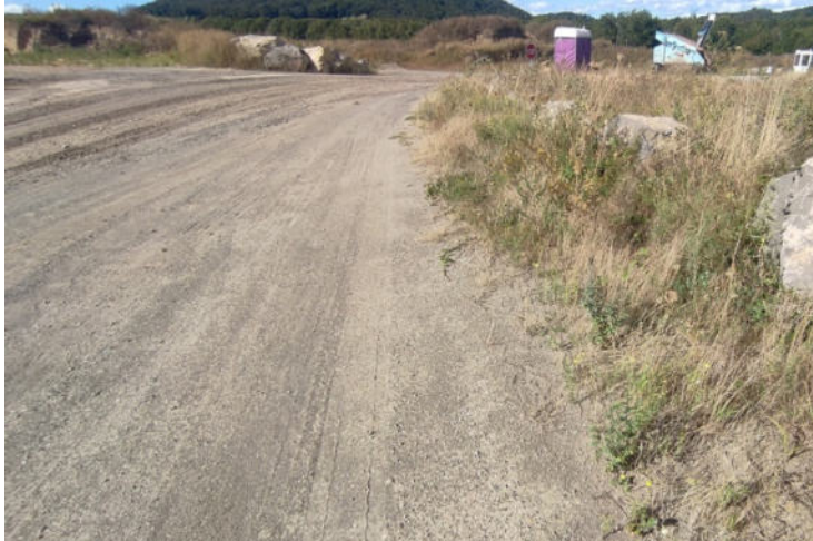
Abbildung 19: befestigter Fahrweg im Abbaugelände in der Teilfläche „Nordwest“
