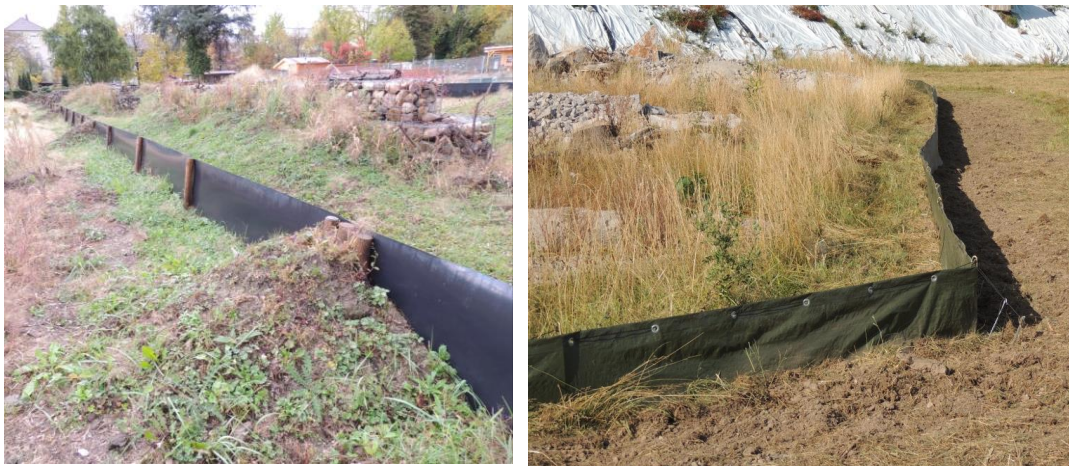
Abbildung 2 Reptilienzaun mit Holzpfählen befestigt oder als Spannsystem, jeweils aus glatter Folie und eingegraben. Der Unterhaltungsaufwand ist aufgrund der geringeren Stabilität und Höhe höher.
