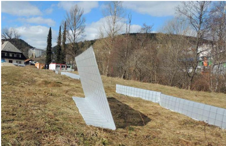
Abbildung 1 Reptilienzaun (Höhe ca. 1,20 cm) aus laminierten Baustahlplatten. Dieser muss ca. 20 cm tief eingegraben werden, bringt aber einen geringen Wartungsaufwand mit sich.
