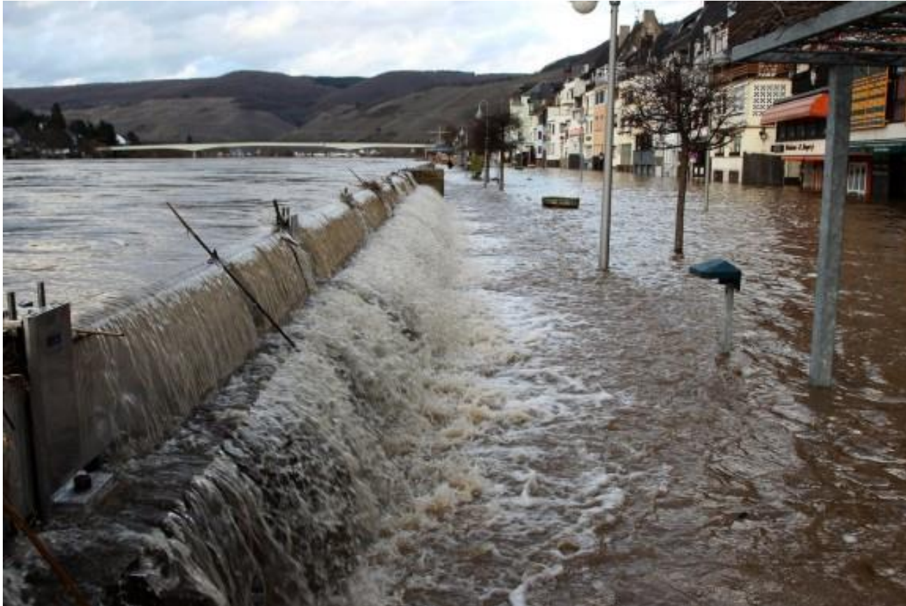
Hochwasserwand mit mobilen Elementen
