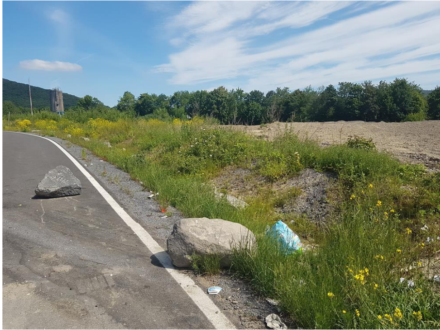
Nördlicher Rand der Straße (Blick Richtung Westen)
