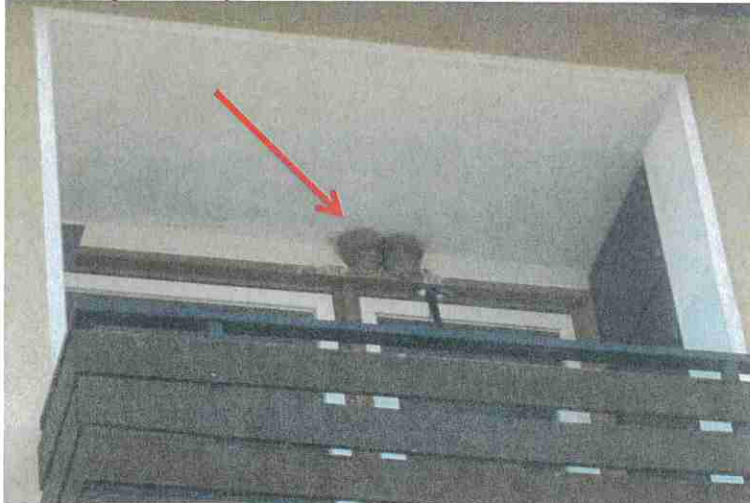
Abbildung 24: Beispiel von besetzten Schwalbennestern bei einem leerstehenden Wohnhaus
