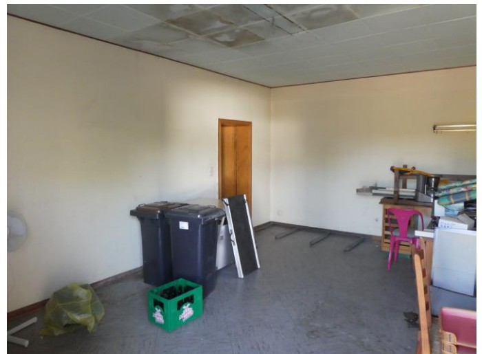
Foto 8: Büro, Detailansicht Fußbodenbelag, Decke
