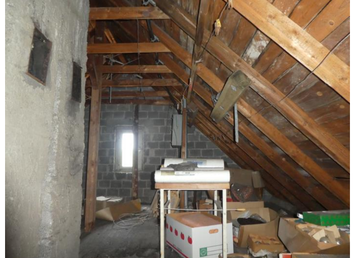
Foto 22: Satteldach, Spitzgiebel, ungedämmt
