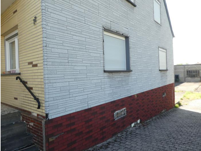
Foto 13: EFH, Westgiebel mit bituminösen Schindeln
