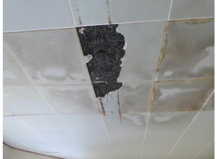
Foto 10: Büro, Detail Decke, Sauerkrautplatten Und Styropor-Dekorplatten
