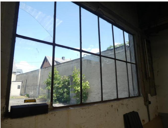
Foto 27: Produktionshalle, Fenster mit asbesthaltigem Kit
