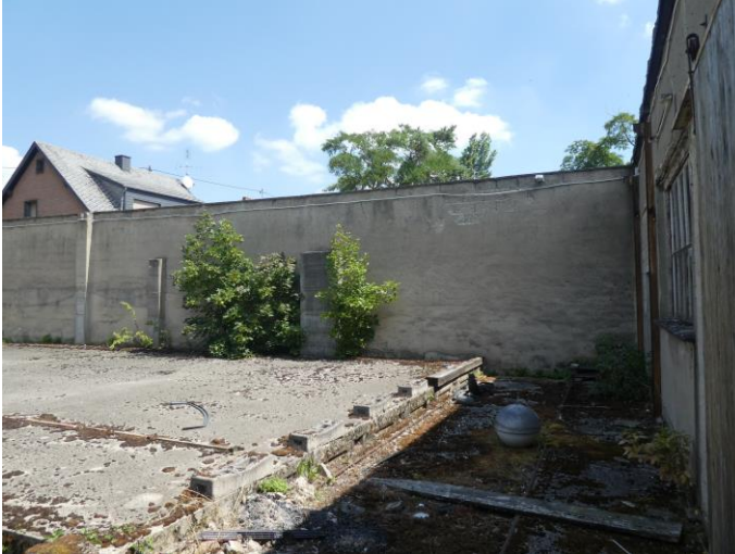
Foto 29: Außenbereich, Grenzmauer und Betonflächen
