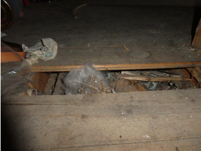
Foto 21: EFH, Dachboden, Holzdielen und KMF Dämmung
