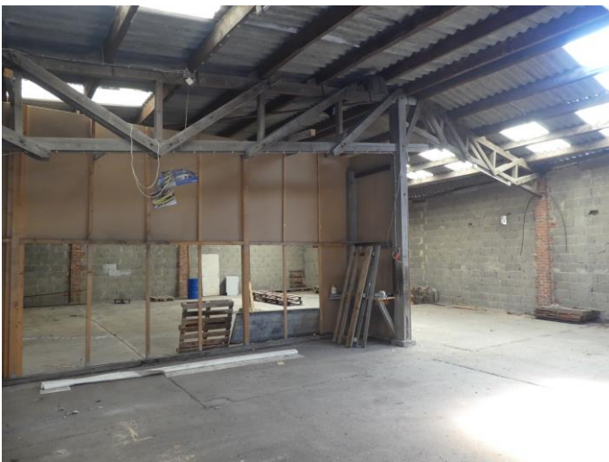
Foto 23: Produktionshalle, AZ-Wellplatten als Dacheindeckung, ungedämmte Ständerwände mit Holzbeplankung
