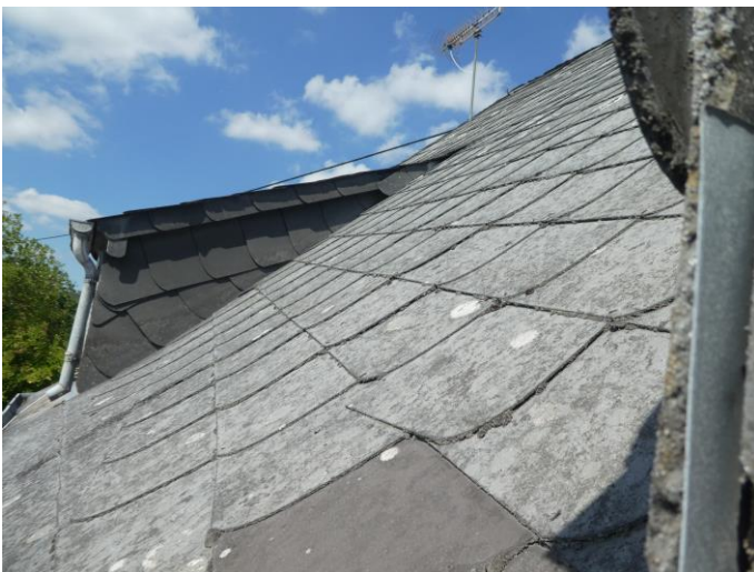
Foto 15: EFH, rückwärtige Dacheindeckung mit AZ-Dachschindeln
