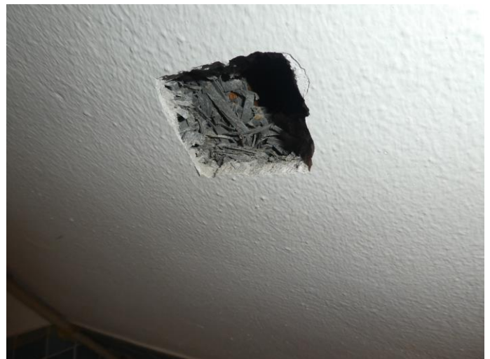
Foto 20: Detail zu Foto 19, Sauerkrautplatten in Den Dachschrägen, gipsverputzt
