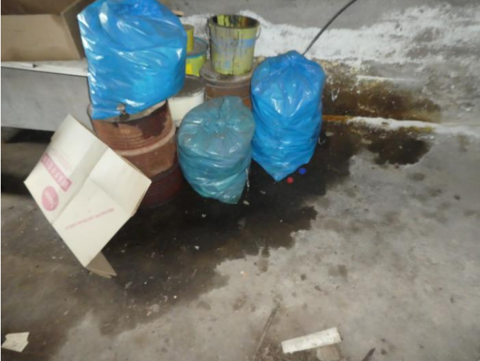
Foto 17: EFH, Keller, Beaufschlagung mit MKW
