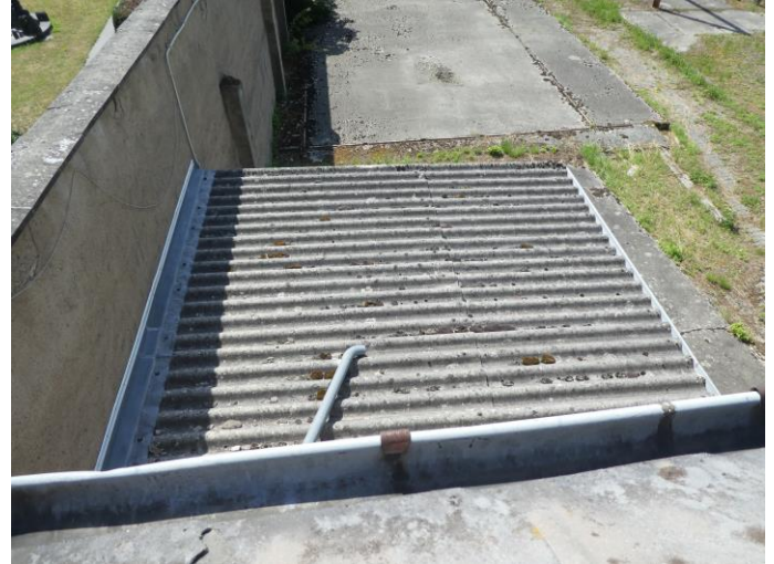
Foto 14: EFH, rückwärtiger Schuppen mit AZ-Wellplatten
